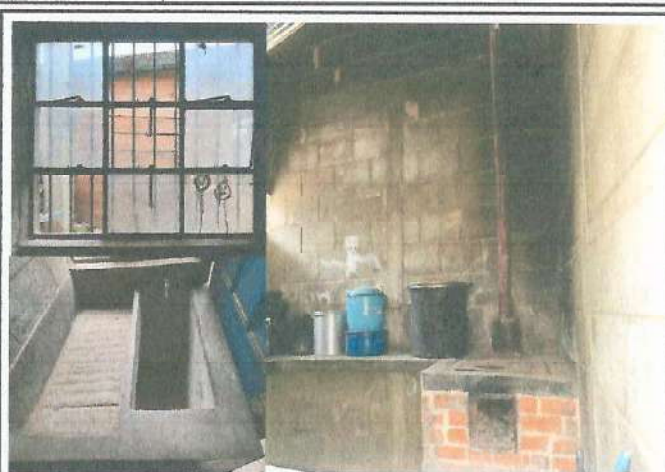
Foto 2: REPARACIÓN Y SUSTITUCIÓN EN ÁREA DE COCINA
