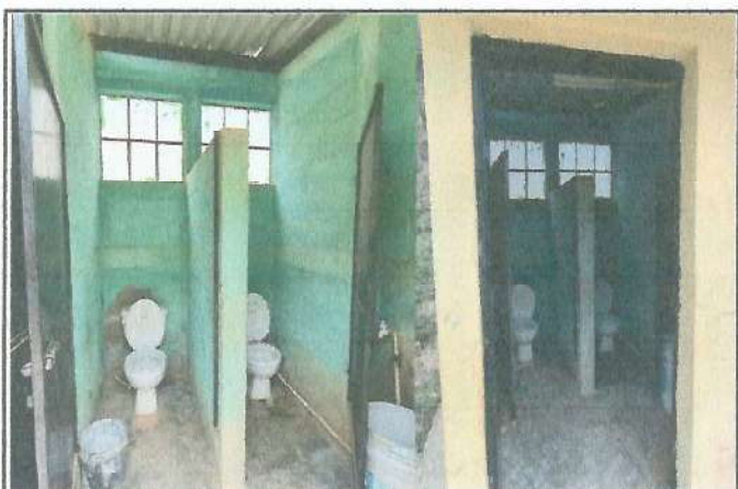
Foto 3: REPARACION DE RED DE DRENAJES
